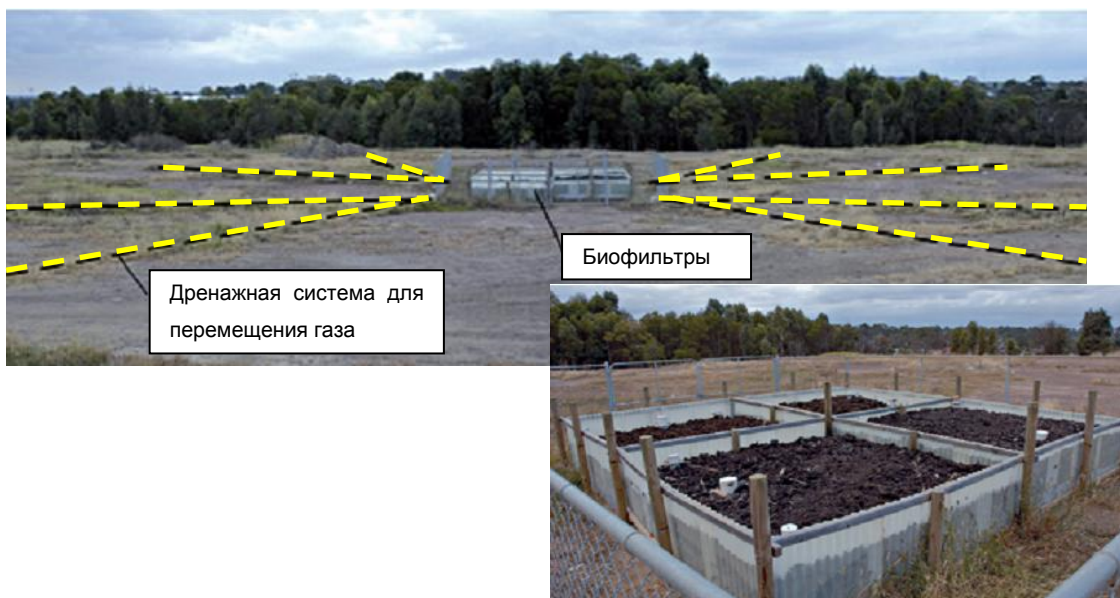
Рис. 3. Схема дренажного поля и расположения ячеек-биофильтров [Using biofilters..., 2007].
